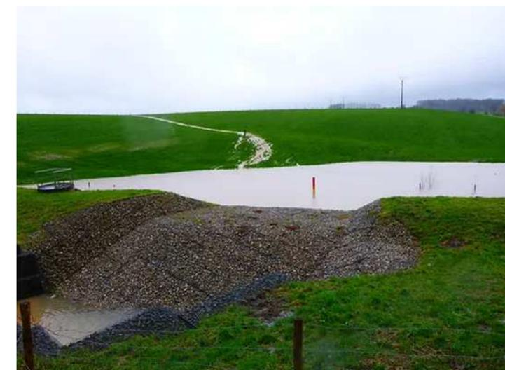
Exemple de surverse de sécurité avec protection de berges
