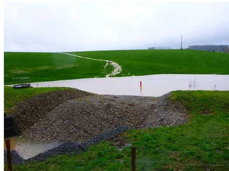
Figure 138 : Exemple d'aménagement pouvant être réalisé visant à limiter l'érosion aval et permettre une meilleure alimentation des zones humides
