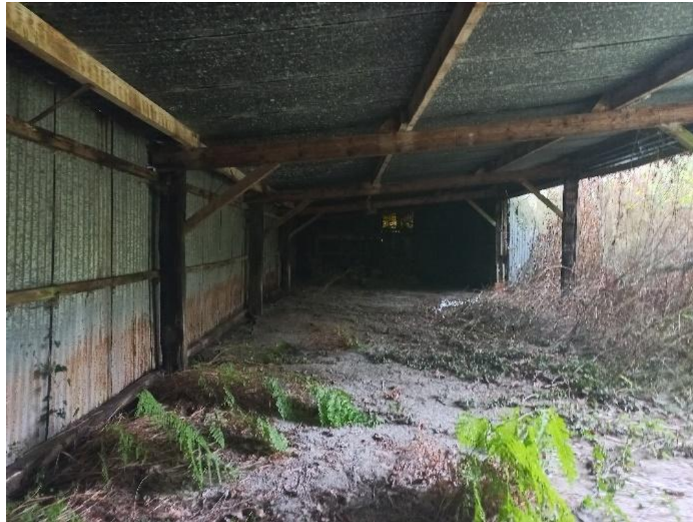
Figure 13 : Hangar à démolir
