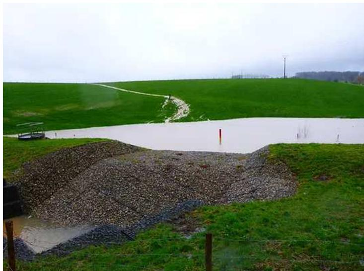
*Figure 37 : Exemple d'aménagement pouvant être réalisé visant à limiter l'érosion aval et permettre une meilleure alimentation des zones humides*
